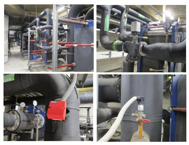
Все установленные температурные датчики имеют чувствительный элемент Pt1000, поддерживаемый многими известными мировыми производителями систем автоматики для отопления, кондиционирования и вентиляции (HVAC). Для измерения давления в старой системе автоматизации использовались реле давления, нами было принято решение о переходе на современные датчики давления. Все датчики температуры и давления примененные в системе автоматизации производства Овен.
